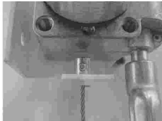
Die beiden Augenschrauben werden nun in das Fallrohr gedreht und die Seile durchgesteckt. Nun Kurbeln Sie den Stoff runter.
